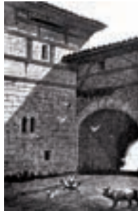
Portal de San Martín de la muralla de Durango (1880).
